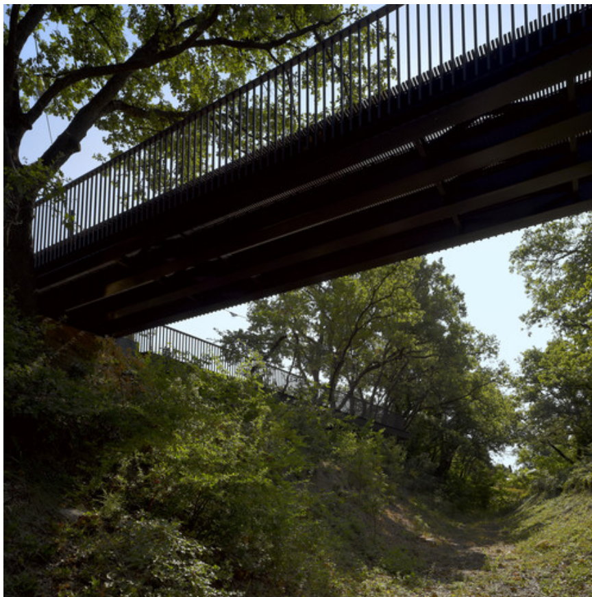
vue passerelle Crédit photo : david giancatarina
