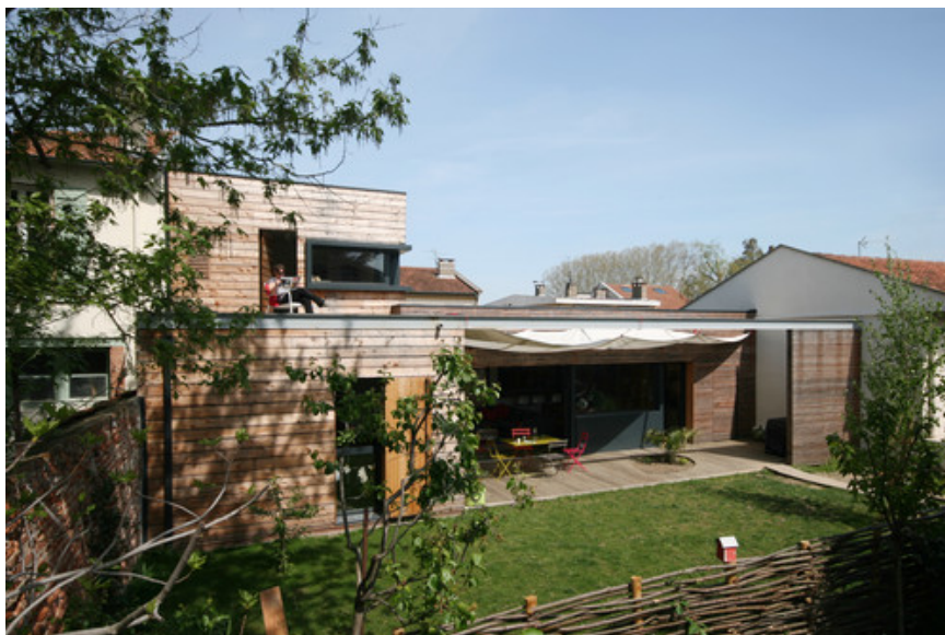
Vue extérieure Crédit photo : copyright archi
