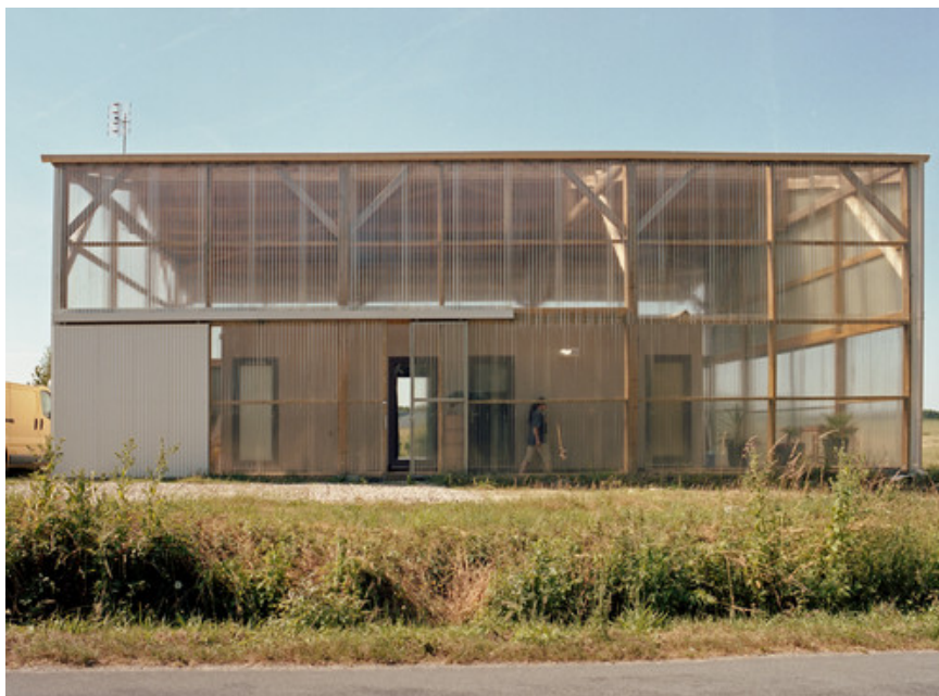
façade nord Crédit photo : Myriam Héaulmé
